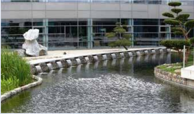
Proyecto Nedap Groenlo, depuración de 700 m 3 de agua con grandes sistemas de filtración.
