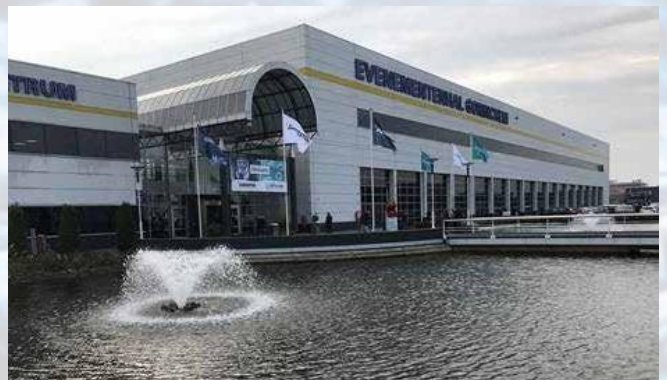
Proyecto Gorinchem, fuentes de aireación y mantenimiento del estanque libre de hielo porque también sirve como estanque de extinción de incendios.
