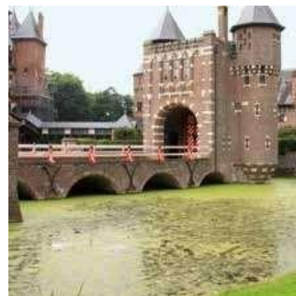
Molestias por olor debido a la falta de oxígeno.
