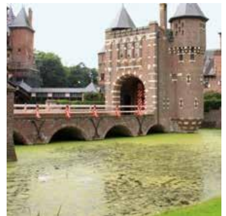
Molestias por olor debido a la falta de oxígeno.
