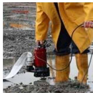
Bombeo de calamidades.
